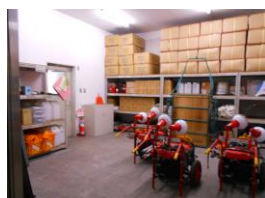
「防災センター」
