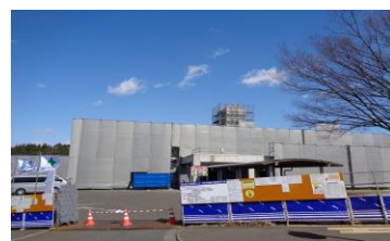
玄関前 外部足場設置状況(R3.3.10)
