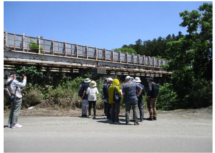
八沢川をまたぐ堤上水路の鉄橋
