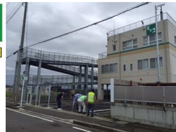
・ビル型（鉄筋コンクリート造） 三本塚津波避難ビル H29.3 完成（250名収容）※消防団施設併設
