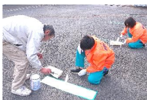
駐車場白線塗装の様子
