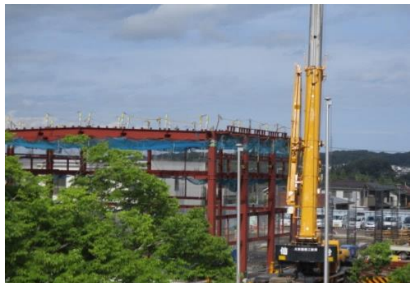
工事現場の様子(令和3年6月17日現在)
